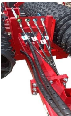
Rysunek 2. Przewody hydrauliczne umocowane prawidłowo.
